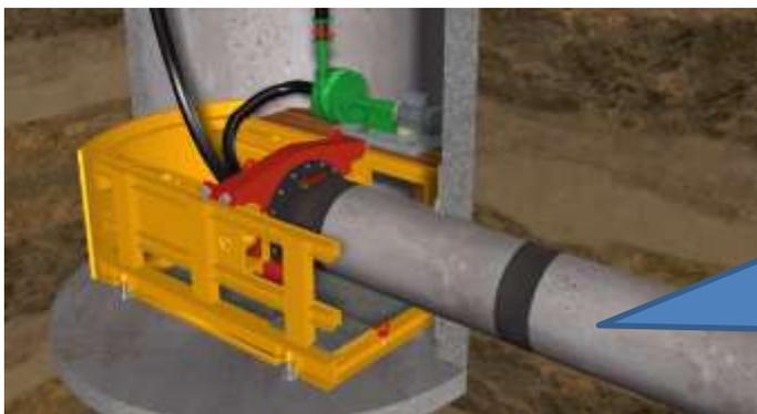
La perforazione prevista in progetto, di diametro 2.200 mm, avviene secondo un tracciato rettilineo (anche se sono consentiti e possibili tracciati leggermente curvilinei), con pendenza della livelletta pari al 0,1%, in salita. Le tolleranze della precisione alla camera di estrazione della fresa sono di pochi centimetri.
